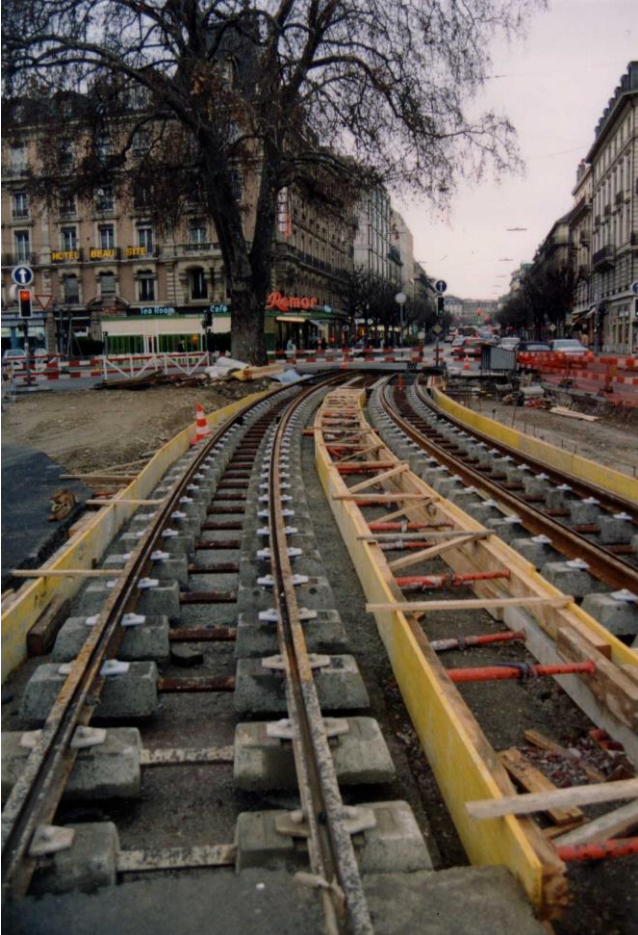
LIGNE 13 - Place du Cirque (traverses bi-blocs)
